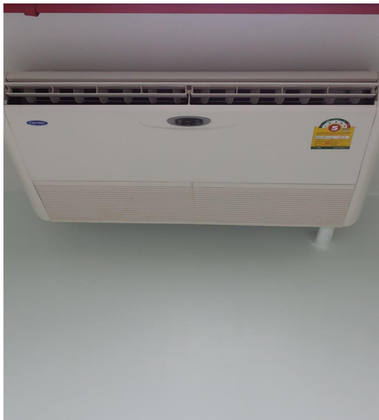
ติดตั้งและเปลี่ยนเครื่องปรับอากาศใหม่ใช้แบบประหยัดไฟเบอร์ 5
